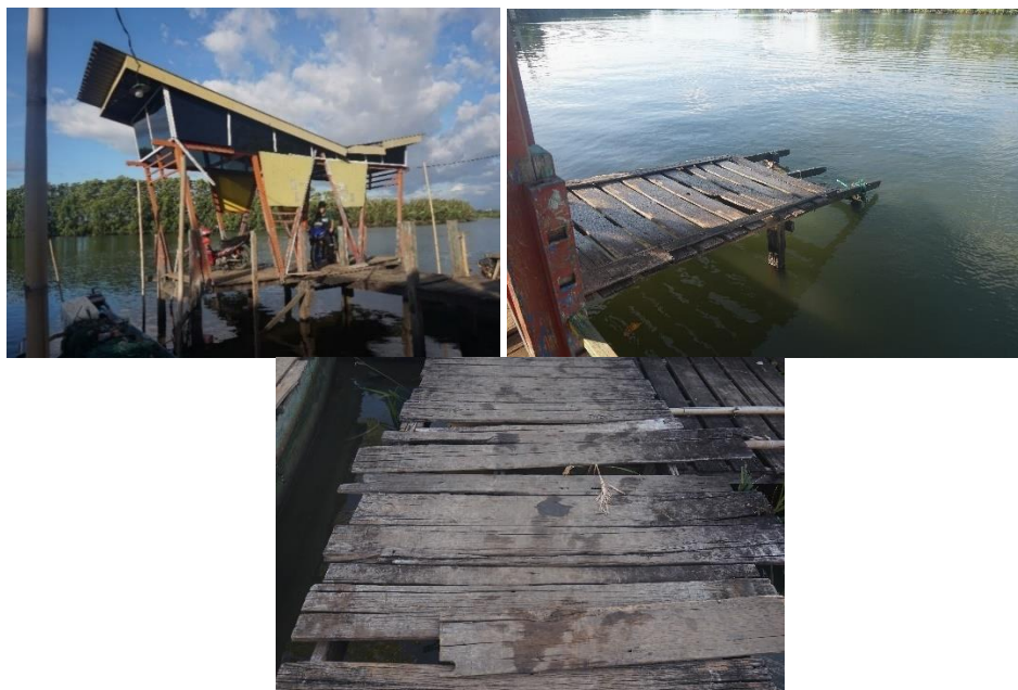
Gambar 4. Kondisi dermaga eksisting
