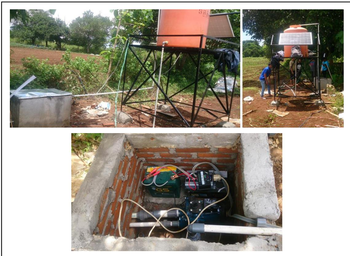
Gambar 1. Instalasi pompa dan pembangkit listrik tenaga matahari
