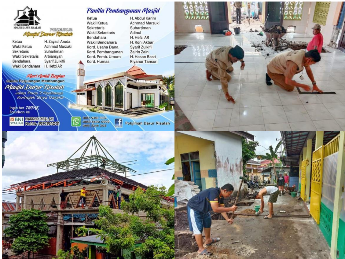
Gambar 8. Perkembangan pekerjaan pada re-desain surau Darur Risalah Pontianak: kiri atas – visual desain surau untuk flyers (November 2020); Kanan atas – pekerjaan konstruksi dan pengukuran arah kiblat oleh tim Kanwil Depag Kalimantan Barat (Desember 2020); Kanan bawah – penyiapan lubang pondasi sesuai gambar rencana (Desember 2020); dan Kiri bawah – Perkembangan konstruksi hingga Juni 2021.
