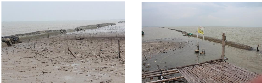
Gambar 9. Sedimentasi di belakang PEGAR karung geotekstil, Pantai Pasir Putih, Karawang (Sulaiman dkk., 2017)
