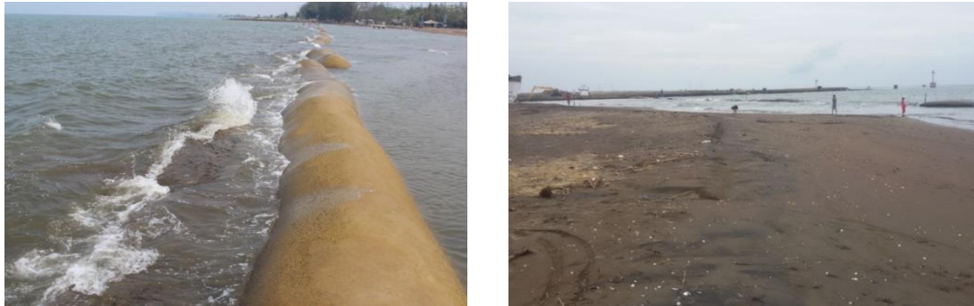
Gambar 8. PEGAR karung geotekstil dan sedimen yang terbentuk di Pantai Sigandu, Batang (Sulaiman dkk., 2015)
