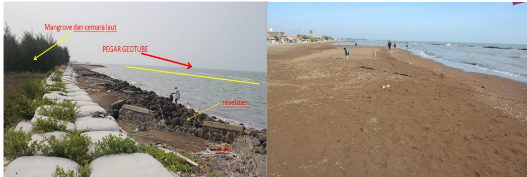
Gambar 4. Penanganan erosi dan banjir rob terpadu di Pantai Pekalongan (Bashir Ahmad dkk., 2015)
