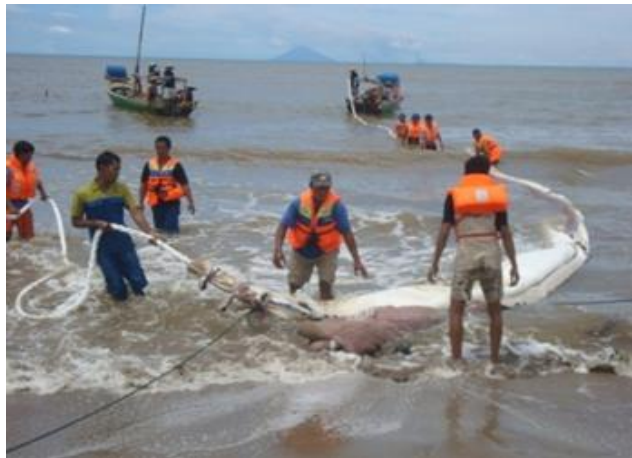
Gambar 2. Pemasangan PEGAR karung geotekstil di pantai Pasir Putih, Anyer (Sulaiman dkk, 2012)
