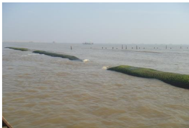
Gambar 3. PEGAR karung geotekstil di pantai Tanjung Kait (Sulaiman dkk., 2012)
