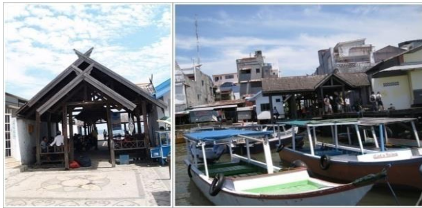
Gambar 1. Struktur Bangunan Dermaga Kayu Bangkoa
