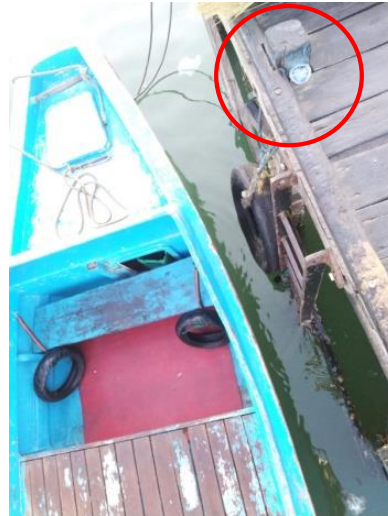
Gambar 7. Tipe boulder tunggal sebagai pengikatan di Dermaga Kayu Bangkoa
