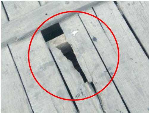
Gambar 6. Lubang pada papan geladak trestle
