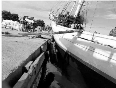
Gambar 4. Fender Pelabuhan Paotere Makassar (Survey)
