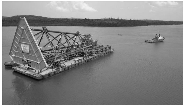
Gambar 1. Proses Transport Struktur ke Tempat Instalasi [2]
