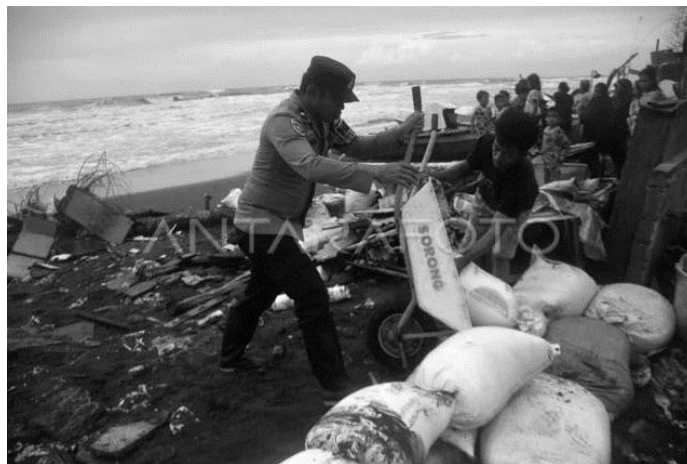
Gambar 8. Pembuatan tanggulan sementara di Kawasan Pesisir Pantai Galesong [11]
