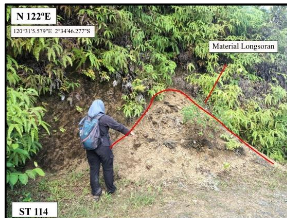
Gambar 11. Material longsor pada ST 114 daerah pinggir Jalan lokal Patila
