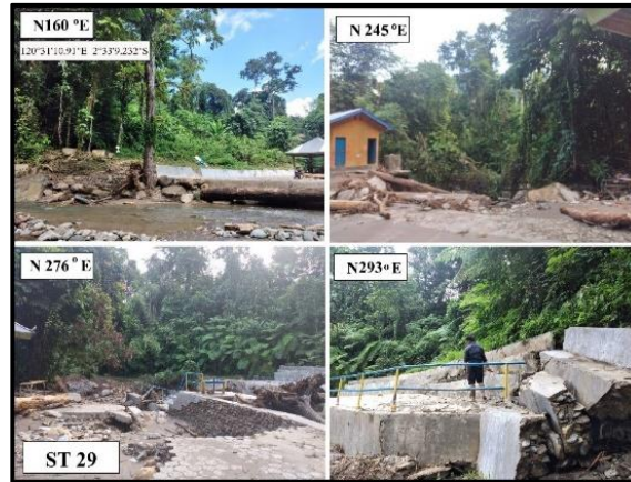
Gambar 10. Dampak Longsor dan Banjir ST 29 daerah Air Terjun Bantimurung yang merusak bendung dan tempat wisata pada aliran Sungai Bone – bone
