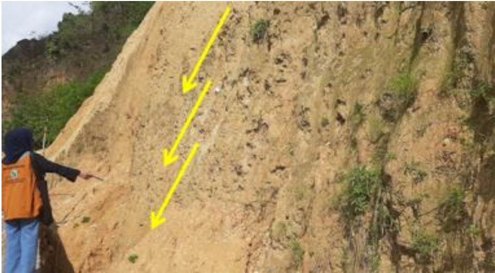
Gambar 10. Kenampakan singkapan batupasir yang rawan terjadi tanah longsor stasiun 3
