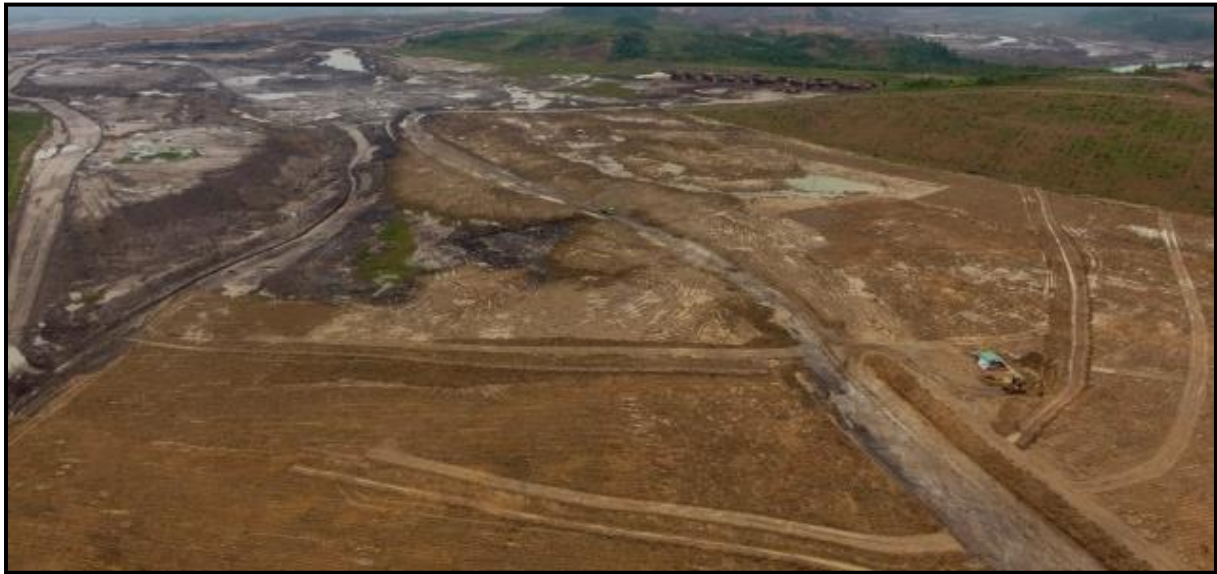
Gambar 4. Proses pembentukan terasering dengan metode teras gulud.
