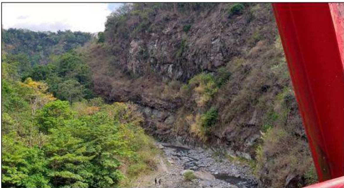
Gambar 2. Kondisi umum lereng lokasi penelitian.
