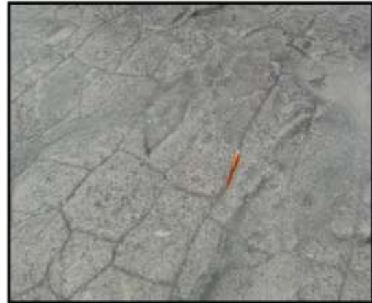
Gambar 3. Kekar gerus ( shear joint ) dengan kondisi air nilai pH 8, warna air bening, tidak berbau dan rasanya tawar.
