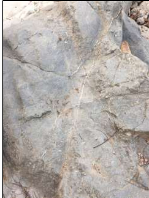
Gambar 9. Rekahan yang tidak terisi mineral.
