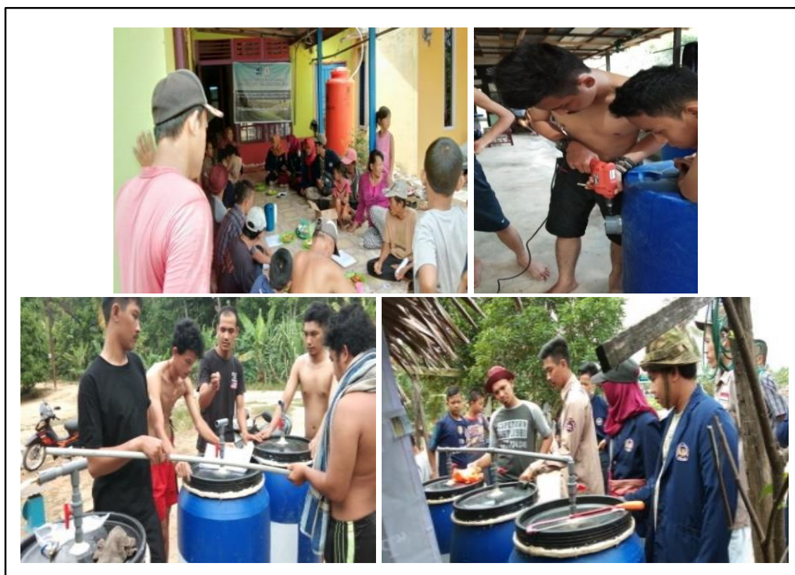
Gambar 1. Pendampingan pembuatan instalasi biogas.
