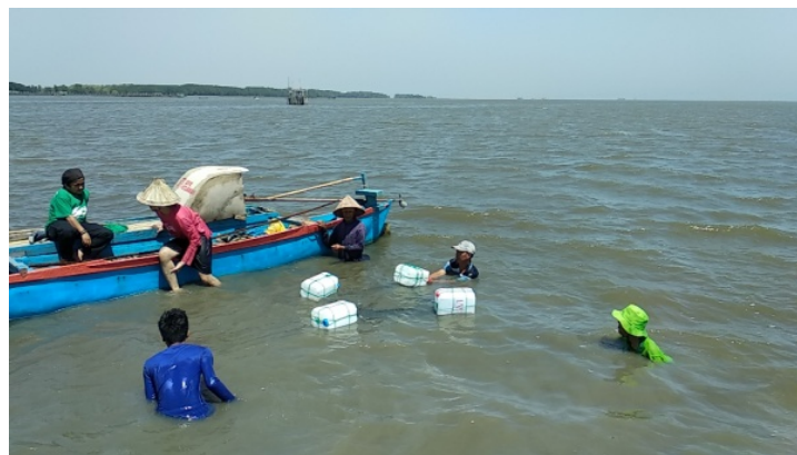
Gambar 4. Pemasangan keramba jaring apung di perairan pesisir Dusun Lantebung.
