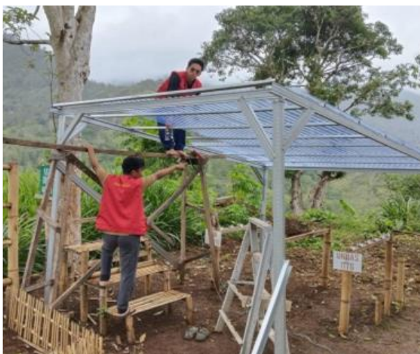
Gambar 1. Pemasangan rangka Greenhouse dan pemasangan atap Greenhouse .
