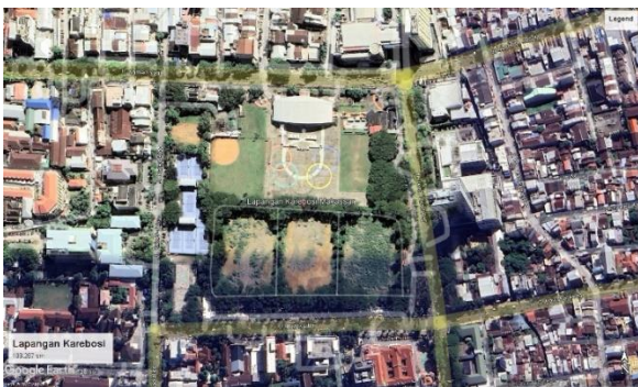
Gambar 1 Tampak Atas Lapangan Karebosi (Sumber: Google Earth 2026)
