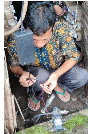
Gambar 6. Pemasangan pompa dan selang input
