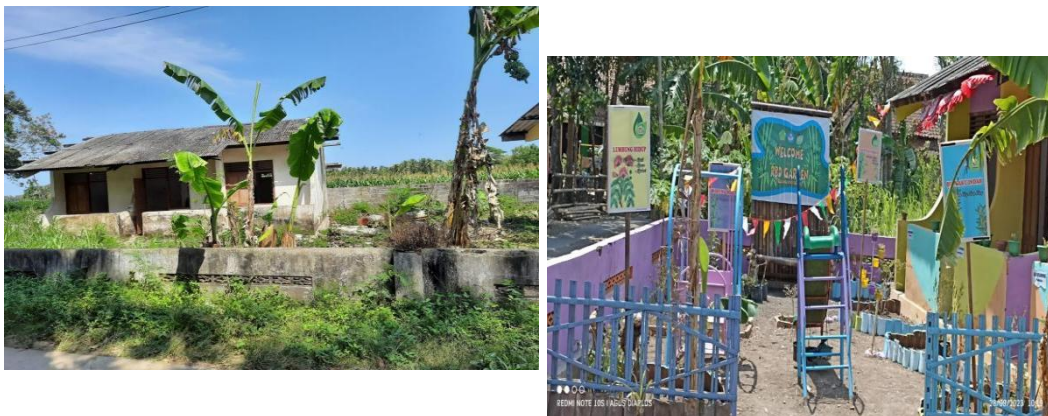
Gambar 3. Kondisi awal dan akhir rumah dinas yang rusak
