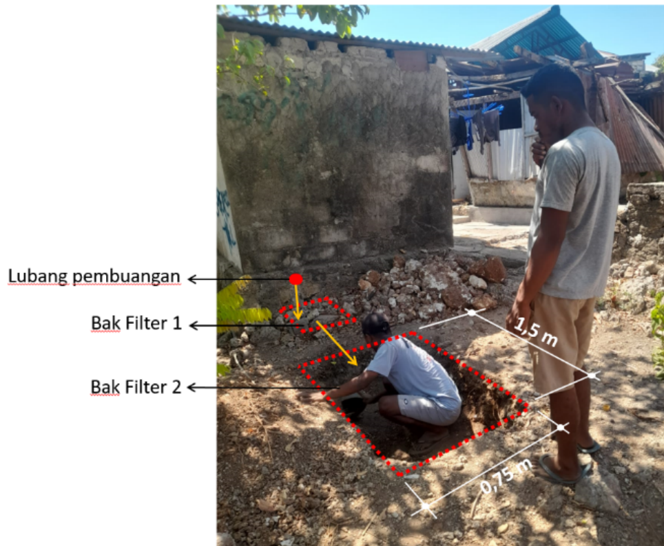
Gambar 4. Rencana Perletakan Instalasi Pada Site
