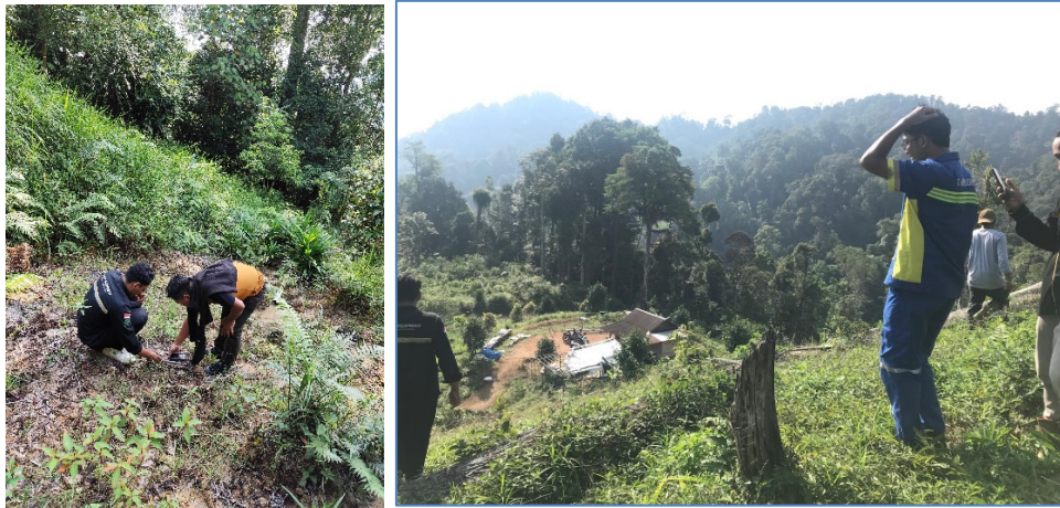
Gambar 3. Pengukuran dan dokumentasi terhadap kondisi eksisting
