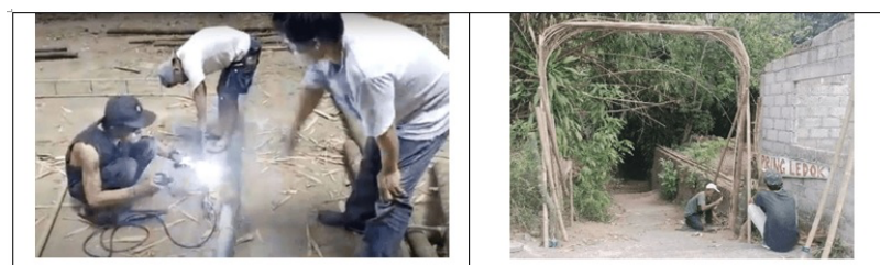
Gambar 7. Membuat kerangka (Kiri) & Pemasangan kerangka instalasi (Kanan)
