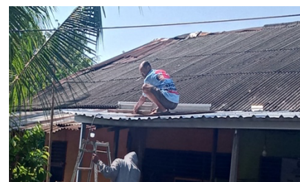
(d) Pemasangan panel surya
