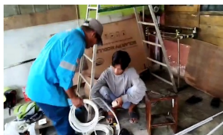
(c) Kabel wiring & penyambungan
