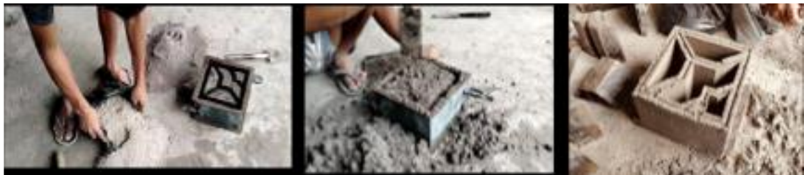
Gambar 4. Dokumentasi Kegiatan Eksperimen Pembuatan Bahan Campuran dan Pencetakan Loster
