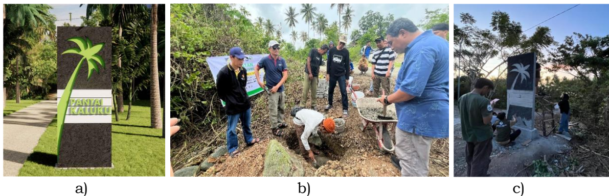
Gambar 5. Tahap Pembangunan Gapura Pantai Kaluku di Desa Limboro a) Desain Gapura; b) Peletakan Batu Pertama; c) Proses Pembangunan Gapura
