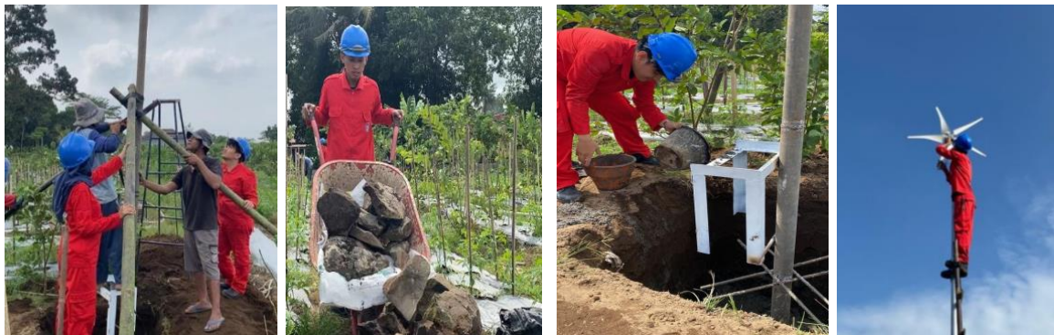
Gambar 1. Proses pembangunan PLTB
