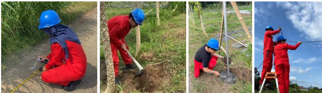
Gambar 4. Proses pembangunan penerangan jalan
