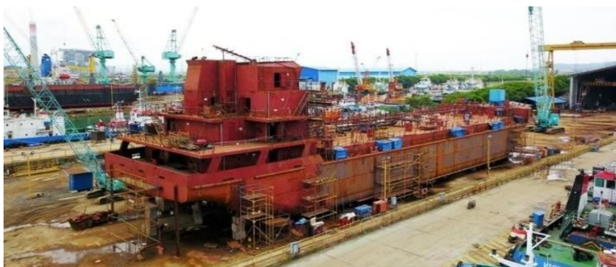
Gambar 1. Pembangunan Kapal OT. Skylic dengan Sistem Pendingin Keel Cooler
