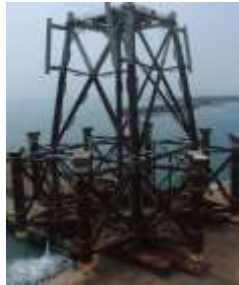
Gambar 1. Proses Load Out dengan Trailer (SPMT) [6]
